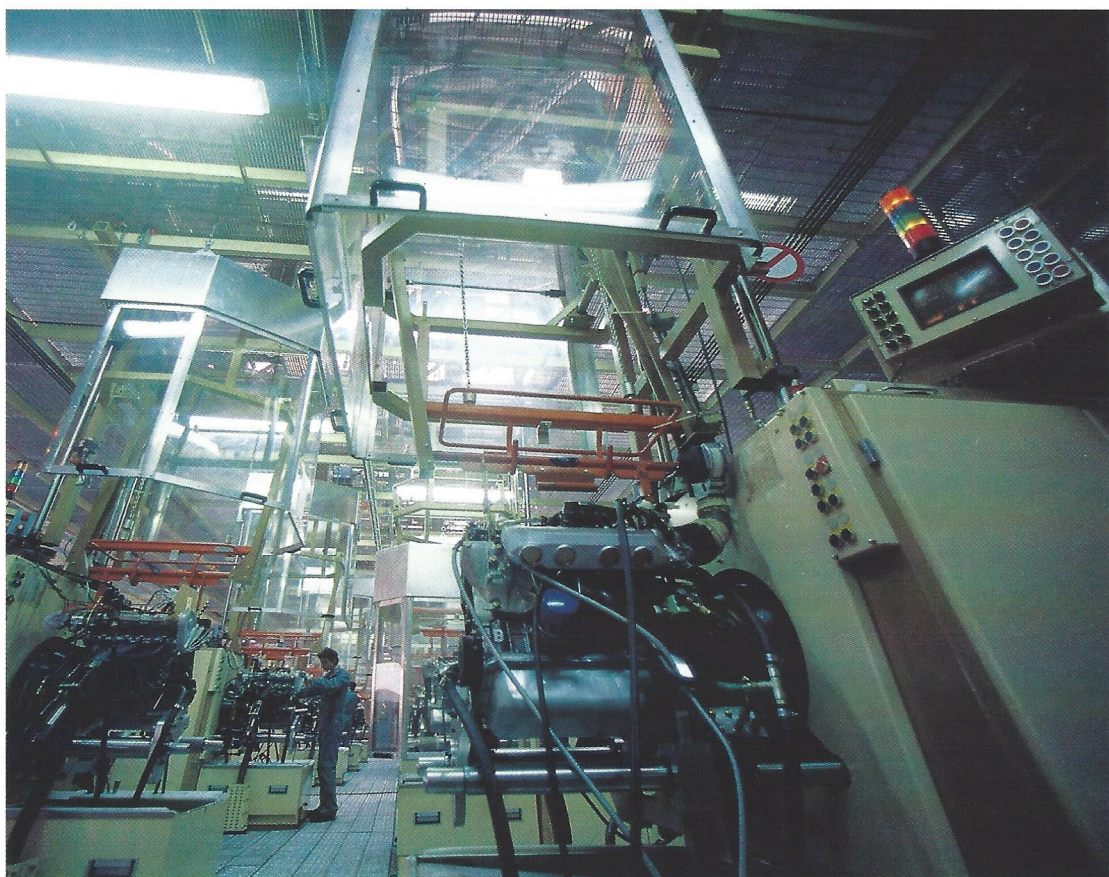
Les bancs d'essais informatisés. Computerized test benches.
